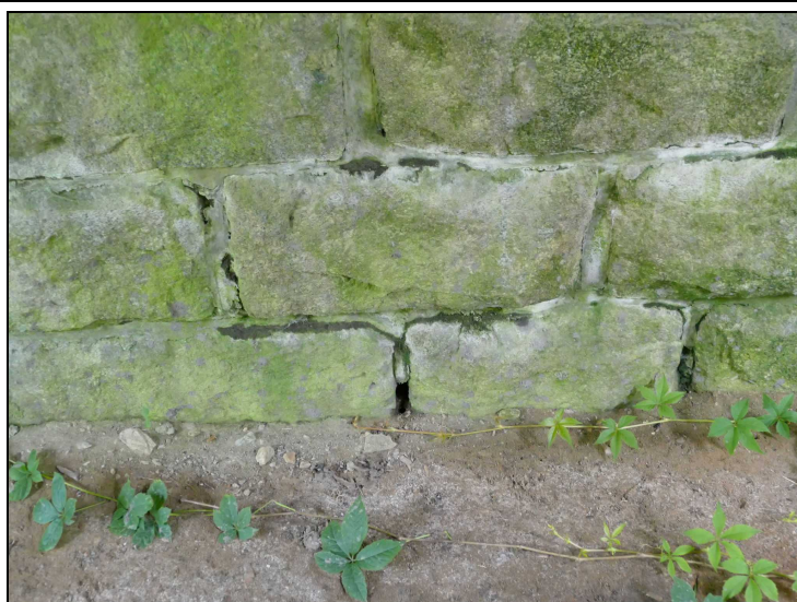
Foto č. 11 – Opěra O 01 – pravá část, vypadané spárování
