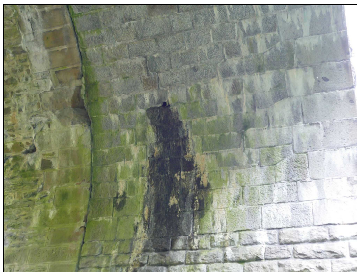
Foto č. 4 – Konstrukce K 02 – podhled vlevo, průsaky vody s výluhy pojiva
