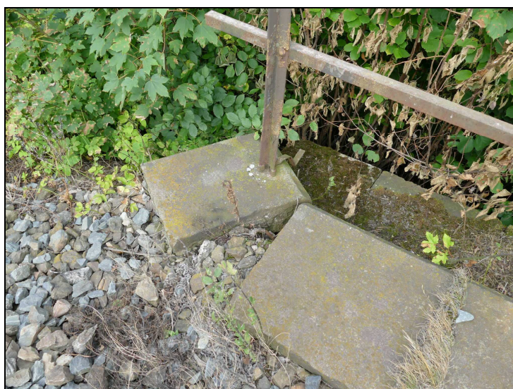
Foto č. 18 – Opěra O 02 – křídlo vpravo, římsa vysunutý kvádr
