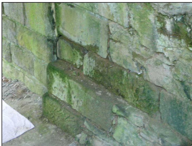
Foto č. 16 – Opěra O 02 – vypadané spárování
