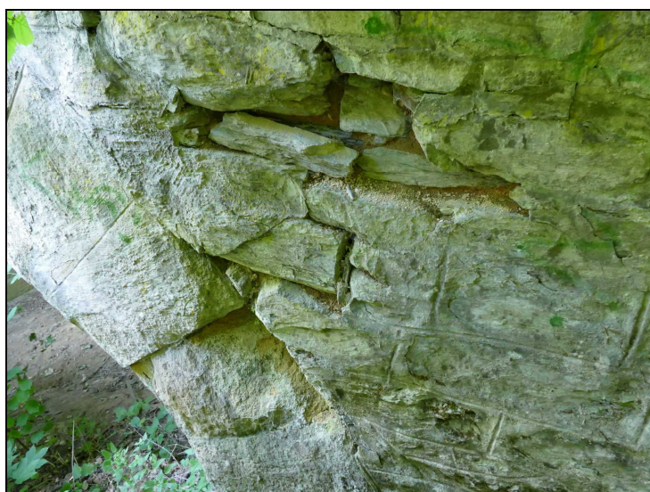
Foto č. 9 – Konstrukce K 03 – čelní zeď vpravo, vypadané spárování, zvětralé klenáky
